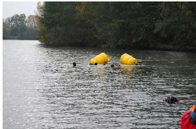
Mit Tragballons wird das Autowrack gehoben und im Wasser transportiert.
